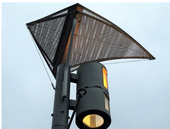
照明振れ止め
