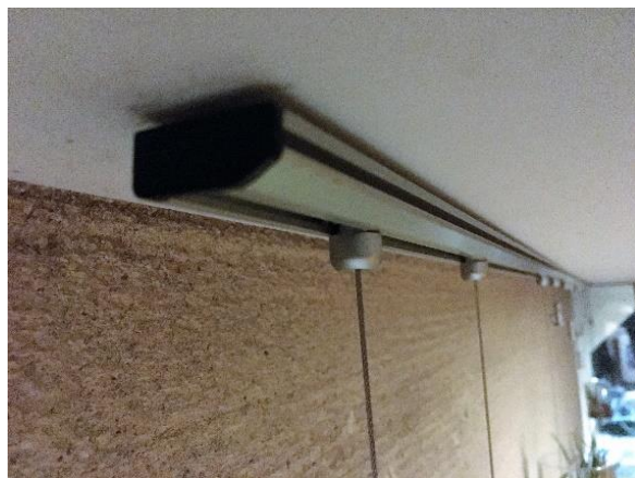
天井にレールをビス止めし取付
