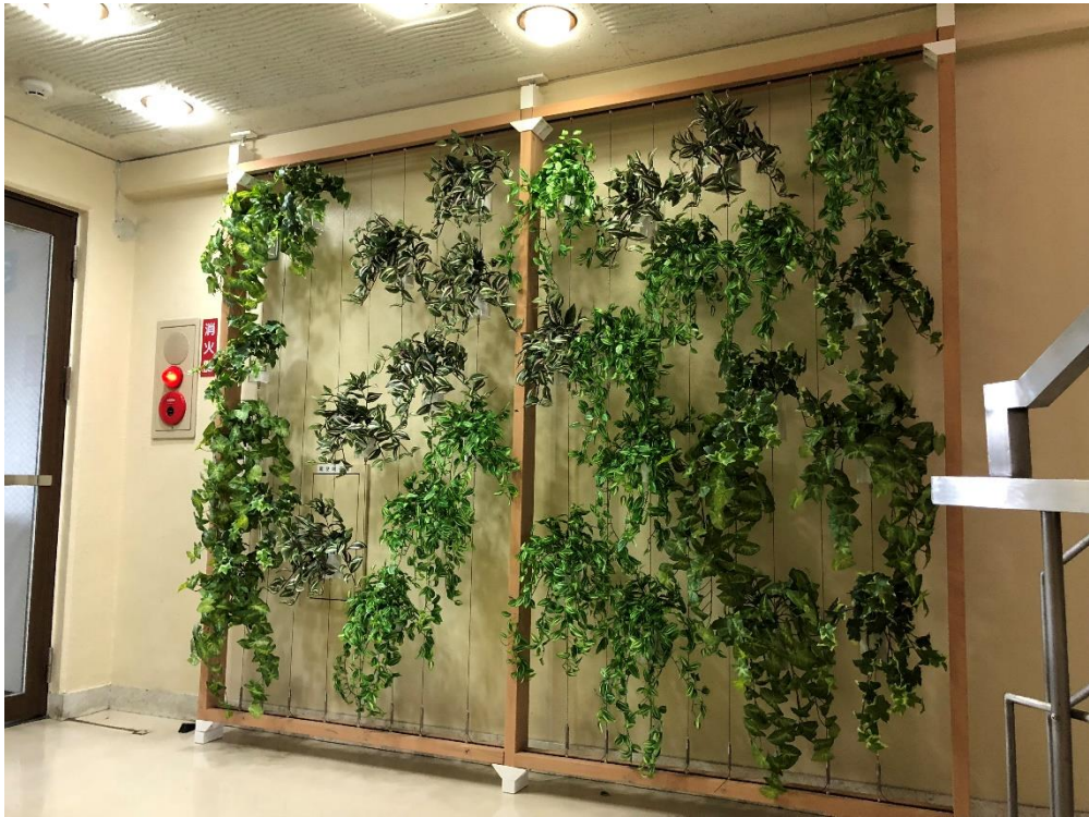
クリニックのエレベーターホールに、空間デザインとして設置。2×4材を使用し、アジャスターで天井部に取付。植栽はフェイクグリーンを使用。 幅2,400×高さ2,500、ワイヤーピッチ@150
