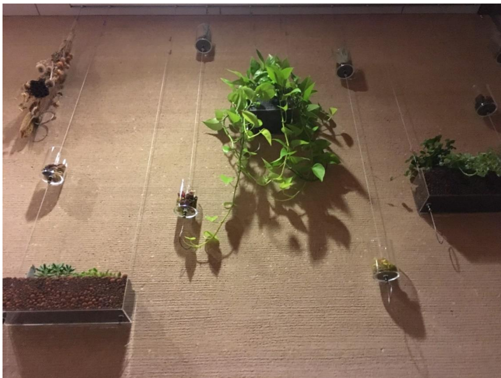
個人宅に、空間デザインとして設置。レールは天井部のみに取付。 幅2,000×高さ2,500、ワイヤーピッチ@200
