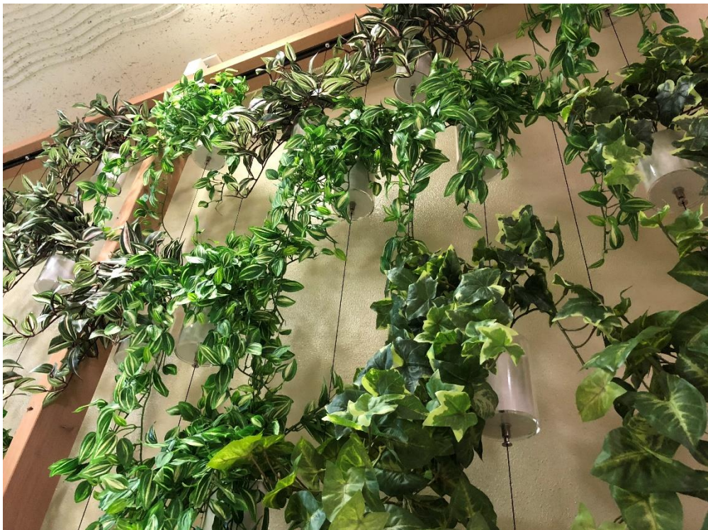
クリニックのエレベーターホールに、空間デザインとして設置。2×4材を使用し、アジャスターで天井部に取付。植栽はフェイクグリーンを使用。 幅2,400×高さ2,500、ワイヤーピッチ@150
