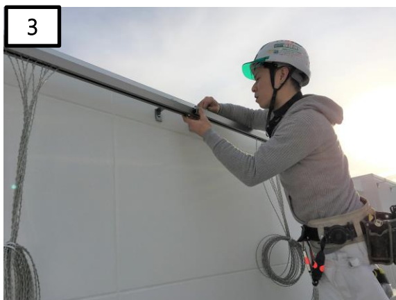
③ 長さ2m以上の場合、ジョイントプレートを使用し、緑化レール同士をボルトで固定する
