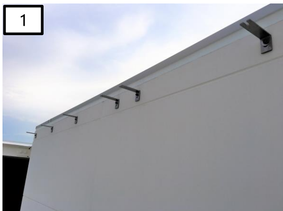
① 設置箇所にL型ブラケットをアンカーボルトで設置する(建築工事)
