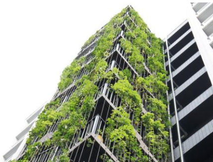
ワイヤー式壁面緑化工法 アルティマ壁面緑化システム (PAT.P)
