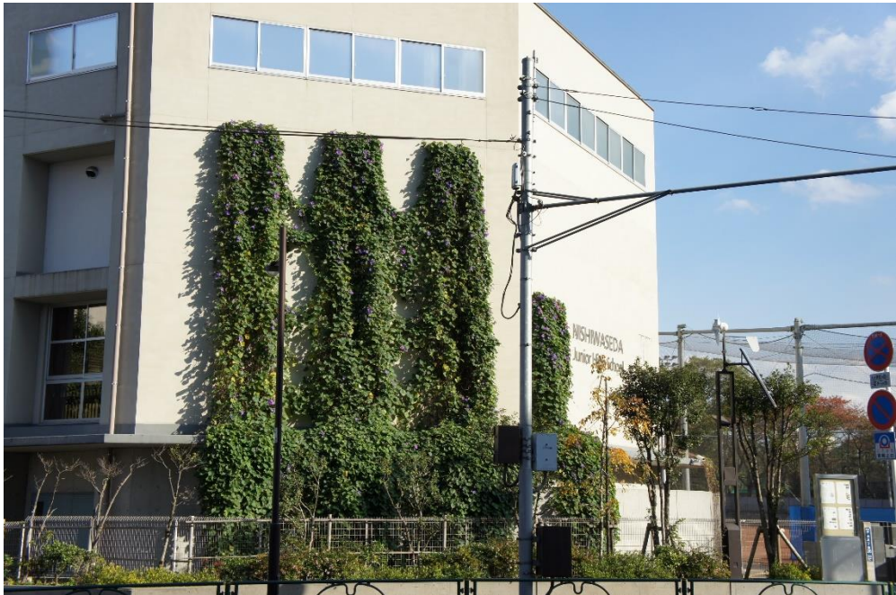
西早稲田中学 ストライプ仕様×支柱：アイボルト付き支柱
