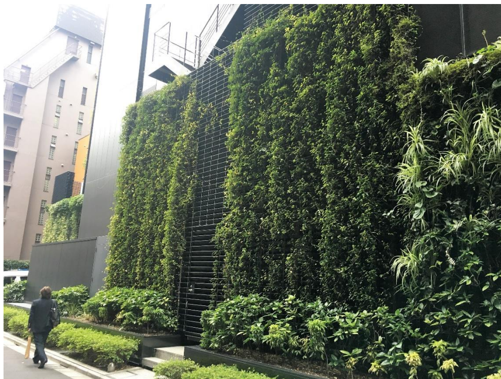
虎ノ門ファーストガーデン ストライプ仕様×支柱：アイボルト付き支柱
