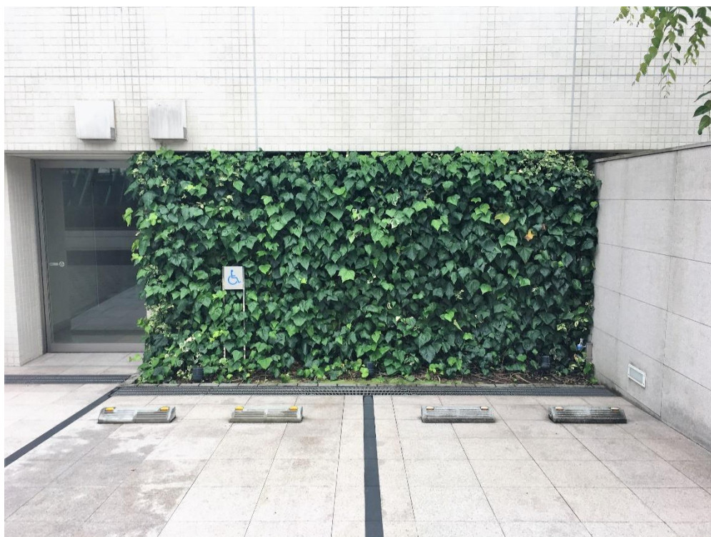
南麻布マンション ストライプ仕様×支柱：アイボルト付き支柱
