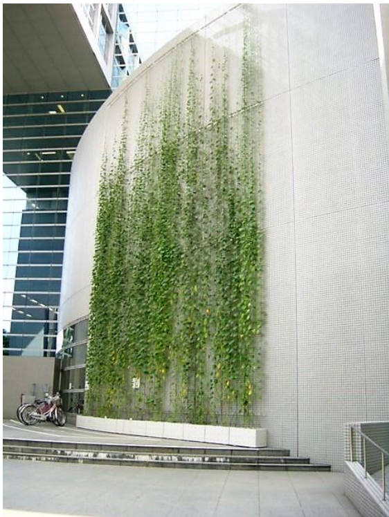
新宿コズミックセンター ストライプ仕様×支柱：Lアングル
