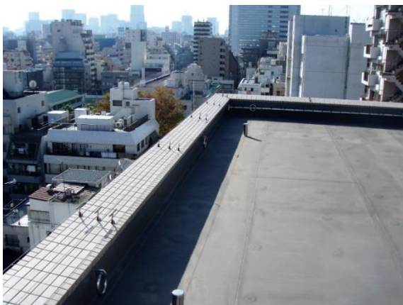
マンション屋上パラペット
