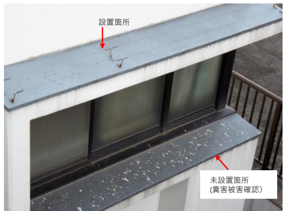
マンション開口底部
