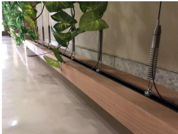
2×4材に溝を切り、ワイヤー取付用のレールを埋め込んでいるので、2×4材からワイヤーが直接出ているので景観を損ないません
