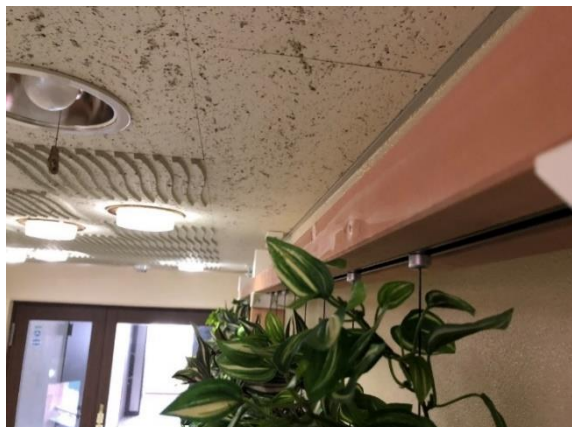
2×4材に溝を切り、ワイヤー取付用のレールを埋め込んでいるので、2×4材からワイヤーが直接出ているので景観を損ないません
