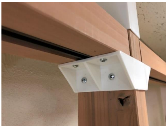
個人宅に、空間デザインとして設置。レールは天井部のみに取り付。 幅2,000×高さ2,500、ワイヤーピッチ@200
