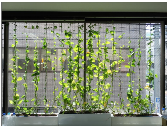
幅2,000mm以上の為、フレーム歪み防止用の縦レールをジョイントし対応 植物：ポトス、パッションフルーツ等 窓枠：幅2,440×高さ1,510、ワイヤーピッチ@120
