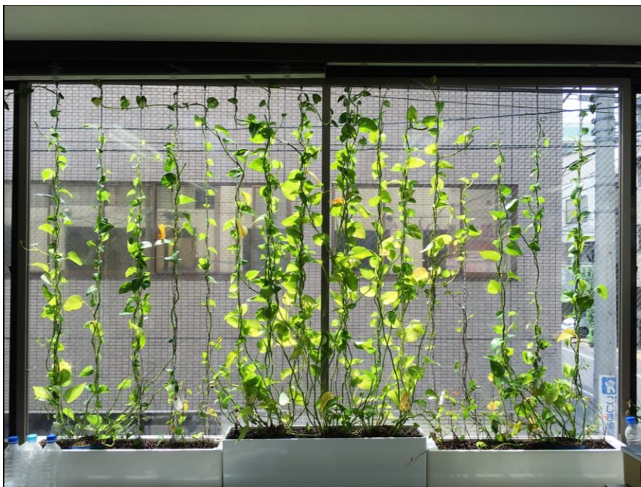
幅2,000mm以上の為、フレーム歪み防止用の縦レールをジョイントし対応 植物：ポトス、パッションフルーツ等、窓枠：幅2,440×高さ1,510、ワイヤーピッチ@120
