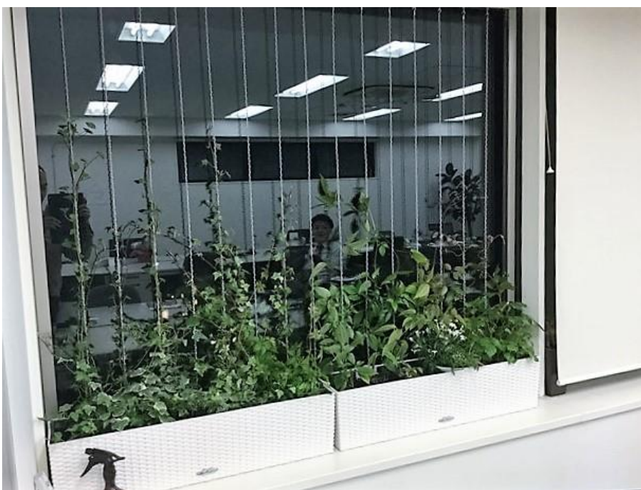
窓枠：幅1,650×高さ1,455、ワイヤーピッチ@100
