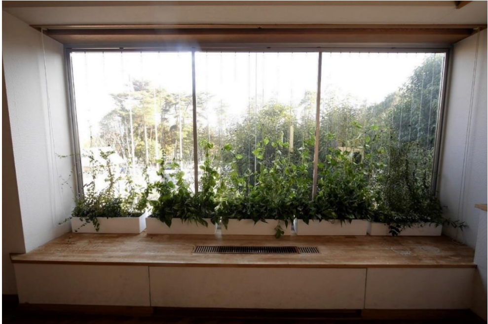
幅2,000mm以上の為、フレーム歪み防止用の縦レールをジョイントし対応 窓枠：幅4,038×高さ1,938、ワイヤーピッチ@200、100
