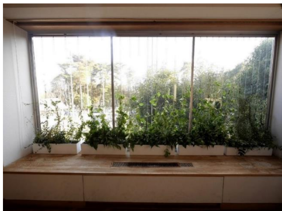
幅2,000mm以上の為、フレーム歪み防止用の縦レールをジョイントし対応。 窓枠：幅4,038×高さ1,938、ワイヤーピッチ@200、100
