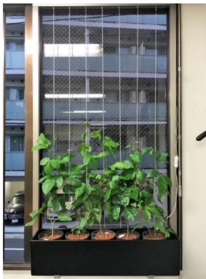
植物：パッションフルーツ 窓枠：幅1,600×高さ1,490 ワイヤーピッチ@100
