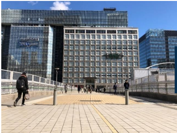
施工前_JR某駅南口こ線橋
