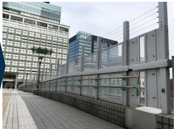
施工後_JR某駅南口こ線橋
