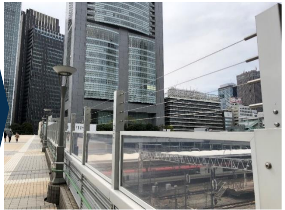
施工後_JR某駅南口ご線橋
