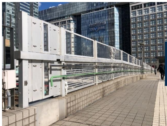
施工前_JR某駅南口ご線橋
