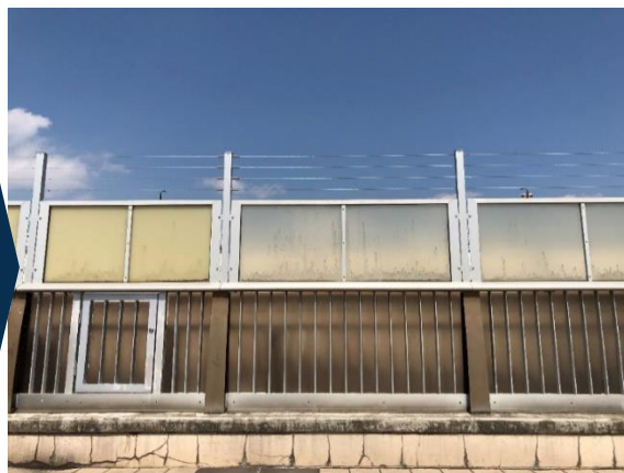
施工後_JR某駅自由通路
