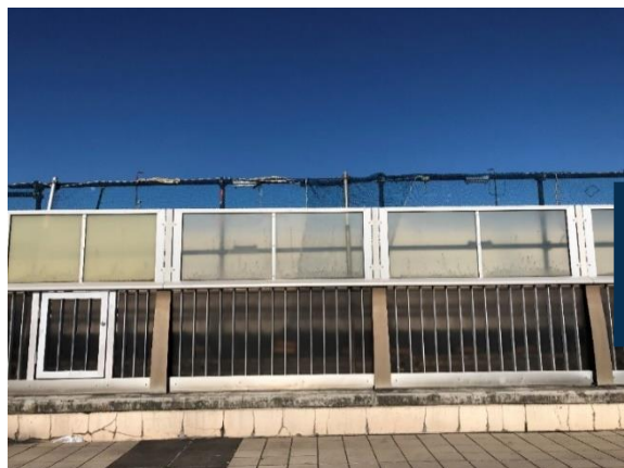
施工前_JR某駅自由通路
