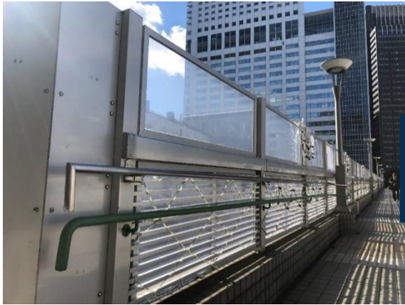
施工前_JR某駅南口ご線橋
