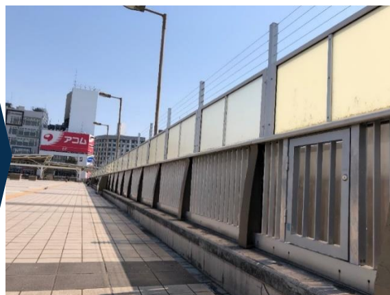
施工後_JR某駅自由通路
