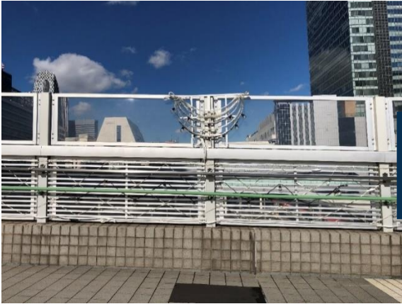
施工前_JR某駅南口ご線橋
