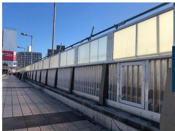
施工前_JR某駅自由通路
