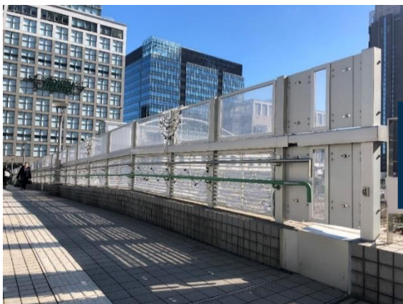
施工前_JR某駅南口こ線橋
