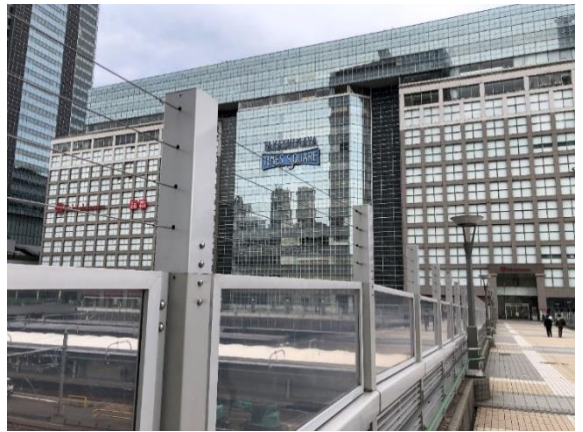
JR某駅南口ご線橋
