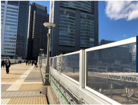
施工前_JR某駅南口ご線橋
