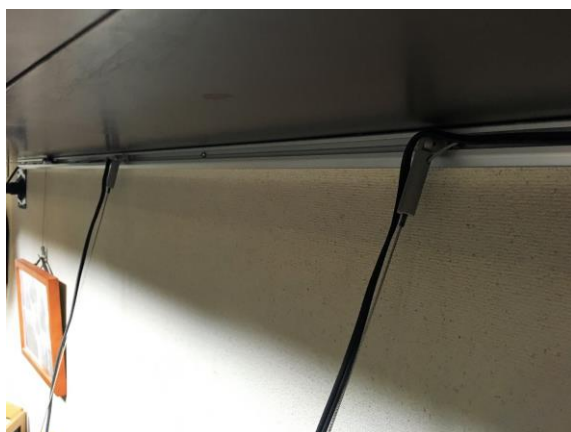
レールからワイヤーを張り出し、テレビ背面に固定します
