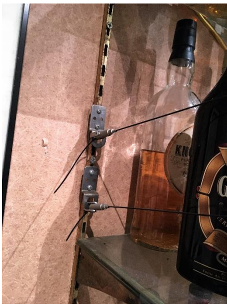
家具ストッパーを壁に固定し、棚に沿ってワイヤーを設置する
