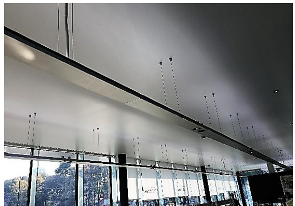
照明器具の吊り下げ
