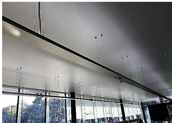
照明器具の吊り下げ
